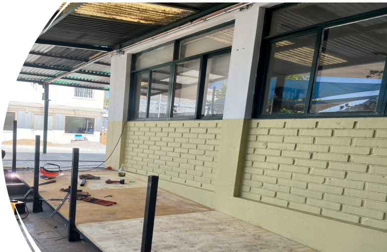
Mejoramiento rampa acceso patio Educación Básica:
