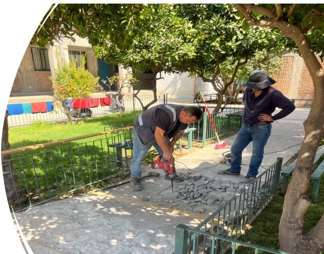
Modificación rampa acceso Patio de los Naranjos:
